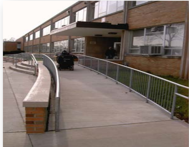
Ramp & Automatic door
